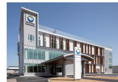
第一三共ケミカルファーマ 小名浜工場 新管理棟
