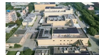
第一三共製薬 (上海) 有限公司 上海工場 太陽光発電設備
